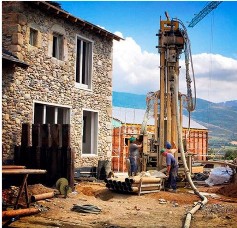
Trabajos de perforación de un pozo vertical
