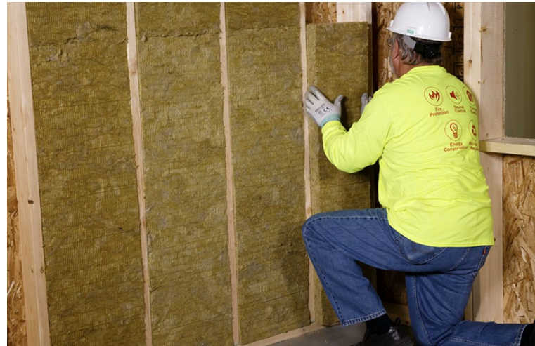
Aislamiento interior Fuente: ralphplastering.co.uk
