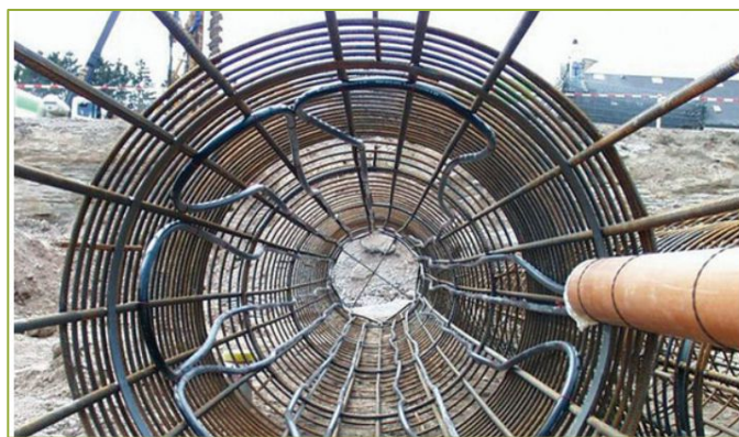
Cijevi integrirane u podrumске stupove
