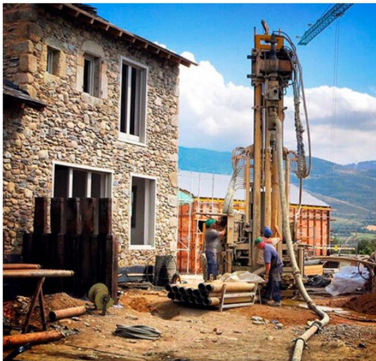
Radovi bušenja za vertikalnu bušotinu
