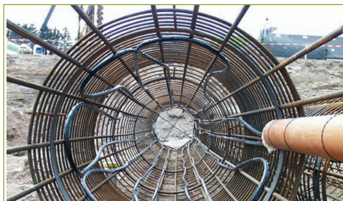
Cevi, vgrajene v kletne pilarde
